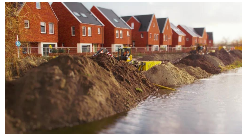
Aanleg van het distributienet van DEVO. Bron: DEVO-Veenendaal
