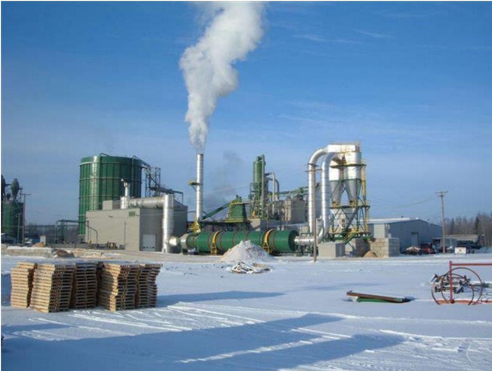
Figuur 9 Overzichtsfoto van een pelletfabriek
