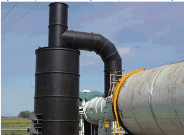
Figuur 10 Cycloonbrander aangesloten op een trommeldroger
